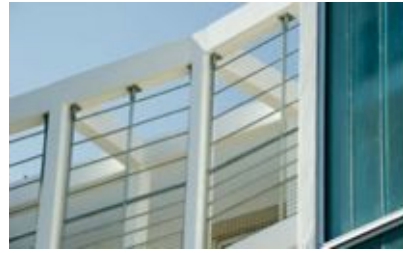
Résidence LE LEVANT 50 logements en accession sociale à la propriété
